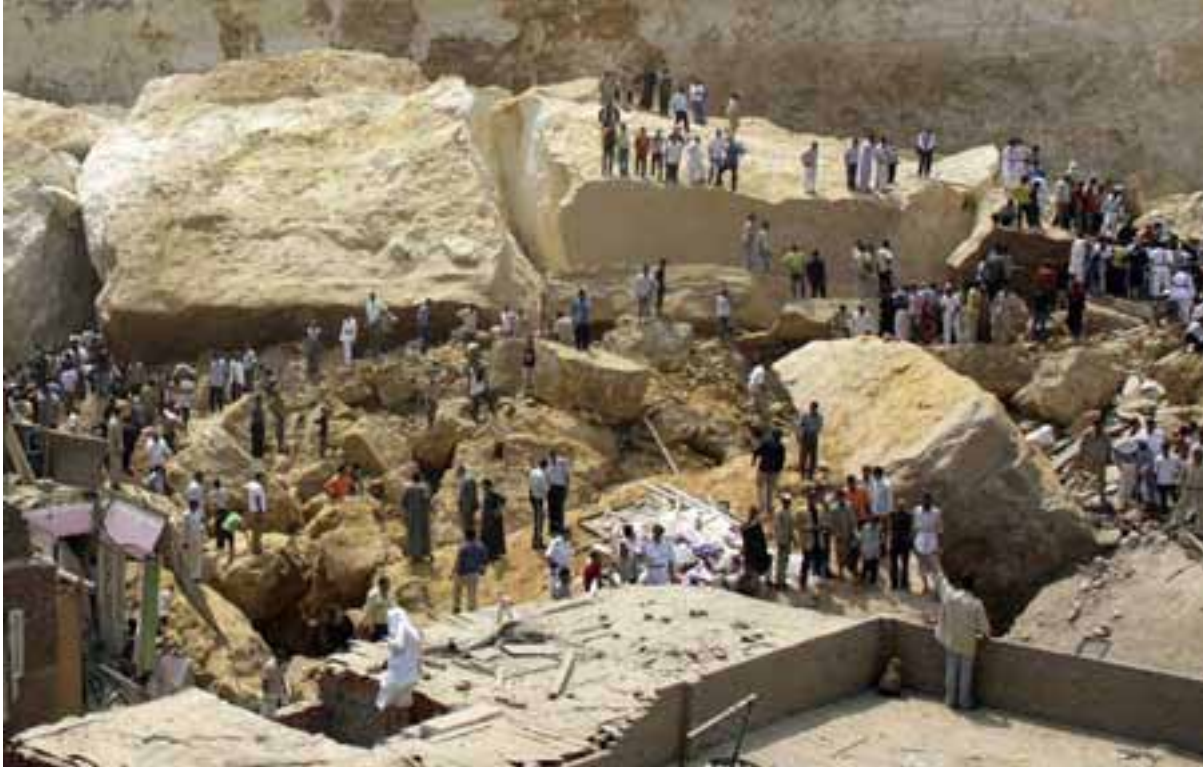
شكل 3.5 أ. كتل صخرية ضخمة ساقطة على المنازل في منطقة الدويقة بمدينة القاهرة في مصر بتاريخ 7/9/2008 [مصدر الصورة: Middle East Online]
