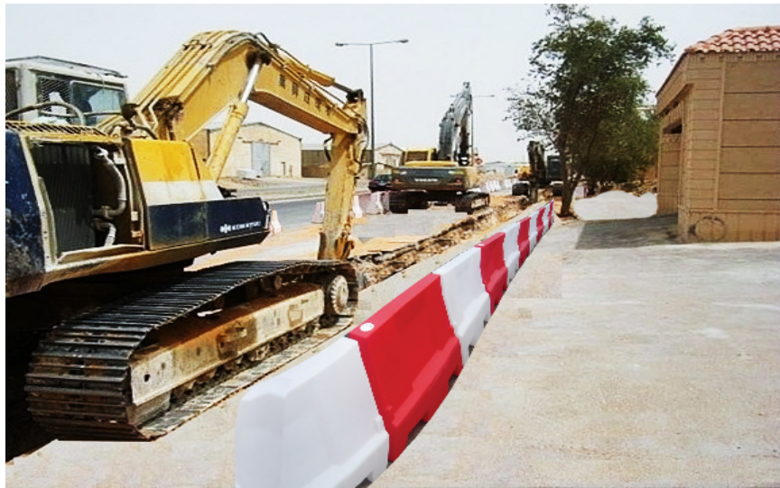
شكل (٥-٣): الحفر التقليدي المفتوح
