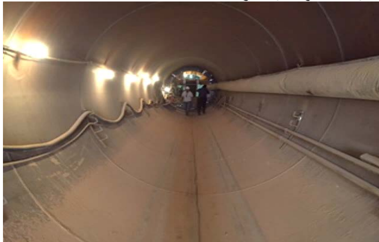
شكل (٥-١٨): تقنية دفع المواسير (ماسورة من الصلب بداخلها بريمة الحفر)
