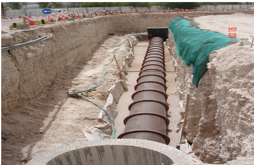
شكل (٥-٣٤): حالة تمديد مرفق وطبقة الحماية له في حفر مفتوح
