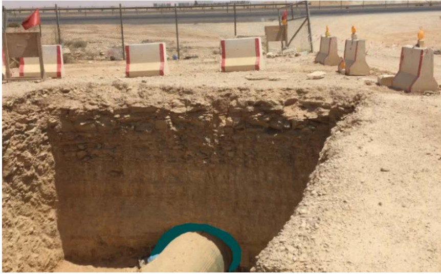
شكل (٥-٣٥): حالة تمديد مرفق وطبقة الحماية له في حفر مغلق
