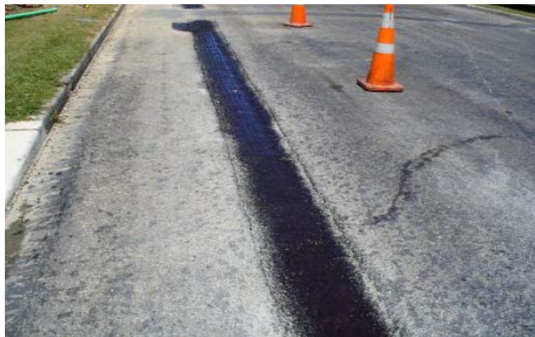
شكل (١١-٥): الطبقة اللاصقة (RC2) أعلى خرسانة إغلاق خندق الحفر الدقيق
