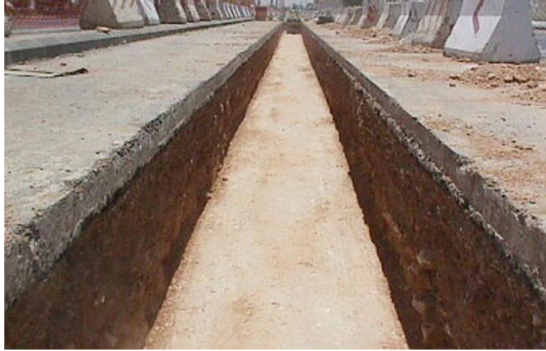
شكل (٥-٣٦): استواء وتجانس سطح طبقة مدكوكة
