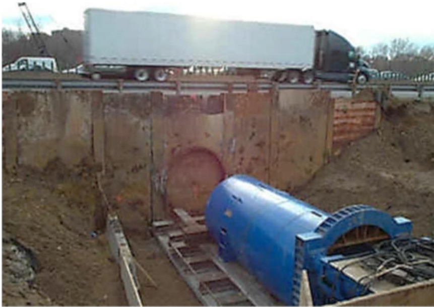
شكل (٥-٢٢): وضع الاستعداد لحفر نفق بتقنية دفع المواسير
