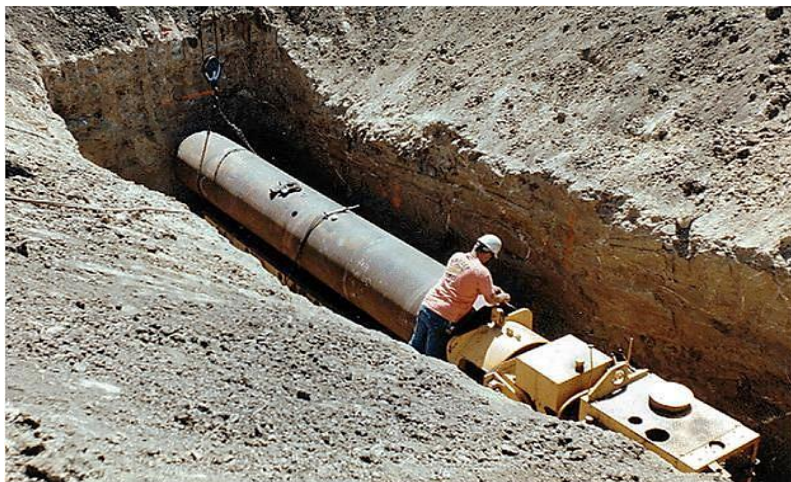
شكل (٥-١٦): حفر النفق الضيق باستخدام البريمة
