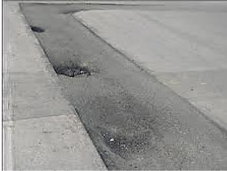
شكل (٢-٣): حفر بسطح الطريق في موقع الحفرية
