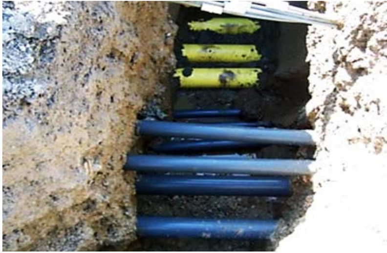
شكل (٥-١٢): حفرة كشف لتحديد مواقع المرافق القائمة
