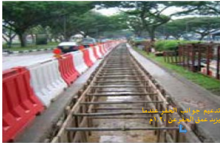
شكل (٥-٢٤): تدعيم جوانب الحفر عند زيادة العمق عن ١,٢٠ م
