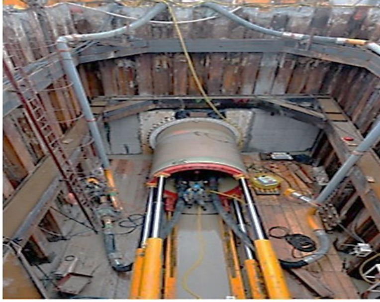
شكل (٥-٢١): تدعيم جوانب حفرة الانطلاق بألواح الصلب (Sheet Piles)
