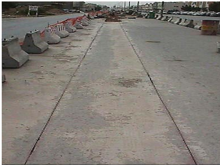
شكل (١-٥): تحديد وقص الطبقة الأسفلتية
