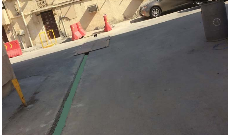
شكل (١٠-٥): إغلاق خندق الحفر الدقيق بالخرسانة ذات اللون الأخضر
