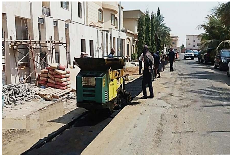
شكل (٥-٤٧): فرد طبقة الأساس الأسفلتي باستخدام الفرادة الميكانيكية
