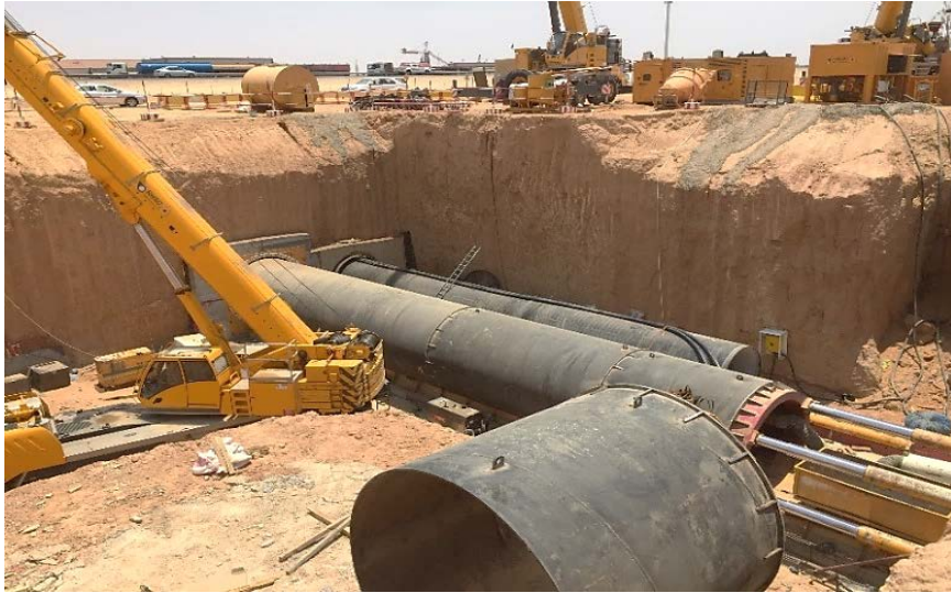
شكل (٥-١٩): دفع المواسير بالمكابس الهيدروليكية
