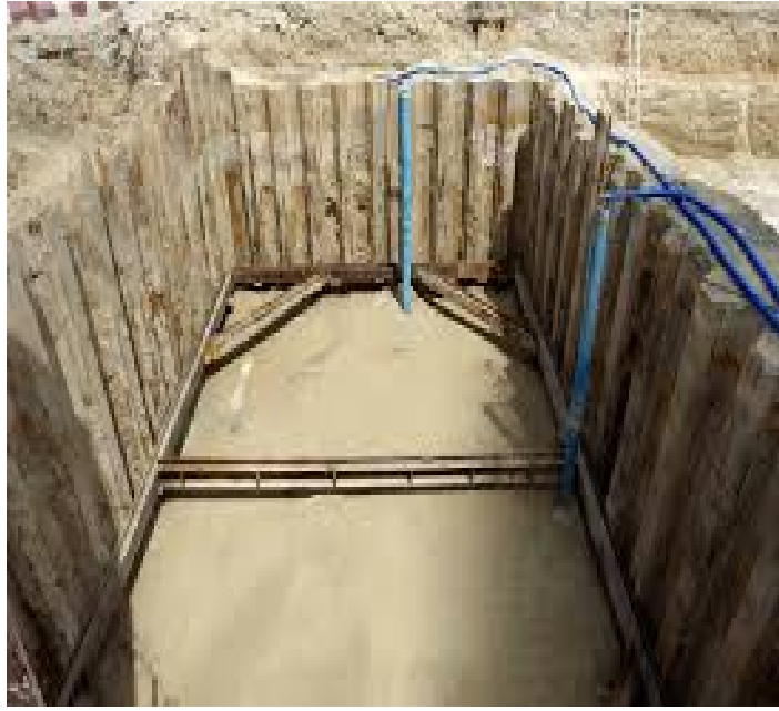
شكل (٥-٢٨): النظام الهيدروليكي لتدعيم جوانب الحفر
