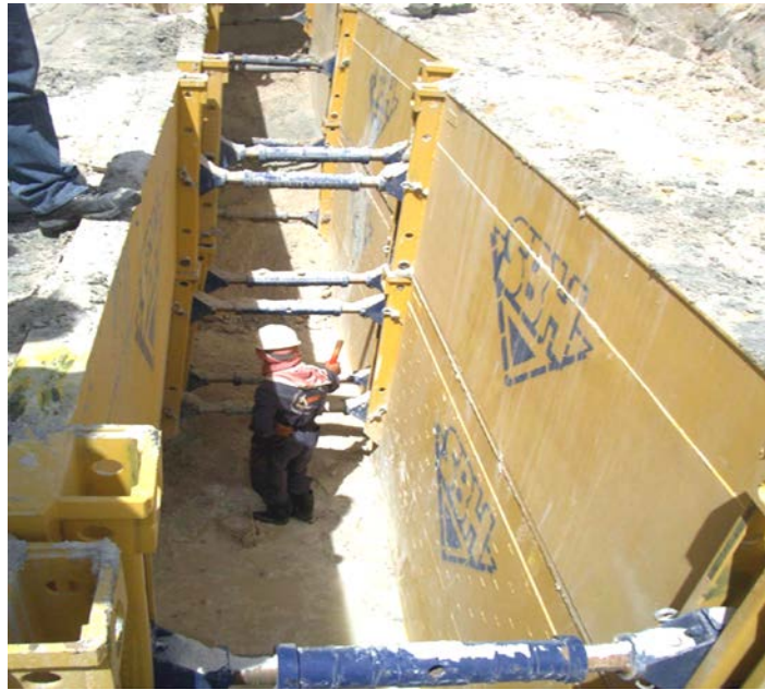
شك (٢٧-٥): نظام تدعيم جوانب الحفر باستخدام الصناديق المعدنية
