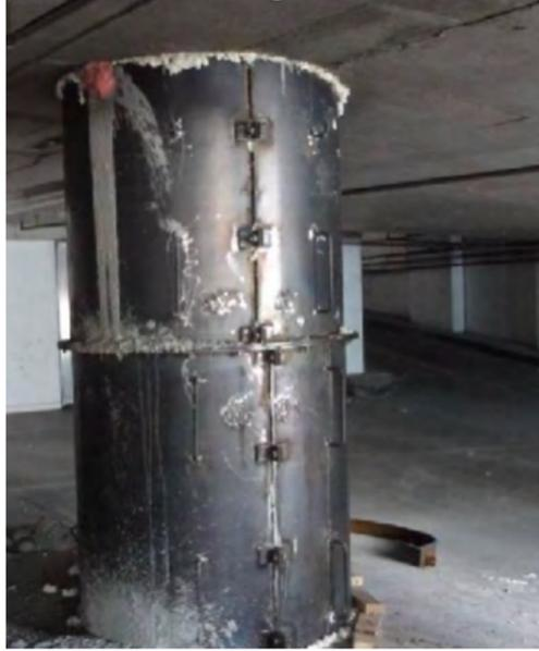
شكل (18) نموذج لعمل قميص تدعيم عمود بالإحاطة الكاملة بالصلب
