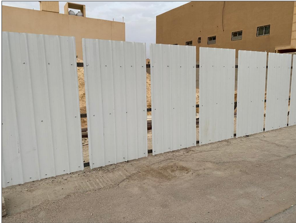
شكل رقم (6): تنفيذ صحيح لسور مؤقت من الألمنيوم الأبيض
