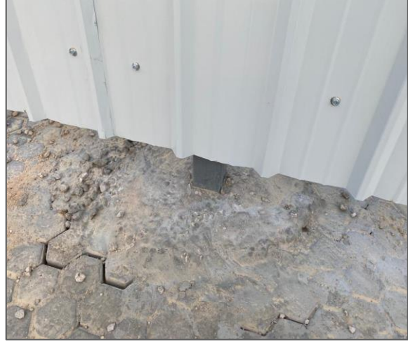
شكل رقم (9): تثبيت خاطئ لأعمدة السور المؤقت
