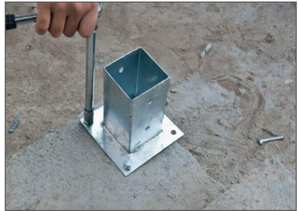
شكل رقم (8): قواعد المنيوم وتيوبات حديد لتثبيت أعمدة السور المؤقت
