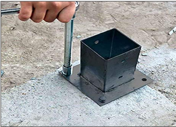
شكل رقم (8): قواعد المنيوم وتيوبات حديد لتثبيت أعمدة السور المؤقت
