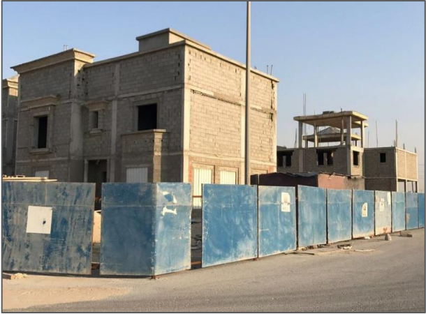
شكل رقم (7): تنفيذ خاطئ لسور مؤقت من المصدات الخرسانية ومواد غير الهنجر
