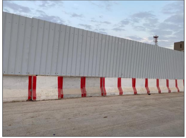
شكل رقم (7): تنفيذ خاطئ لسور مؤقت من المصدات الخرسانية ومواد غير الهنجر
