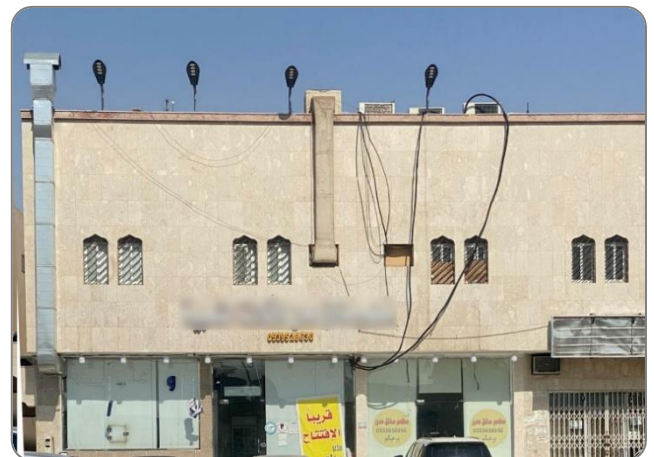
شكل (5): تمديدات كهربائية وصحية (مخالفة) في واجهة المبنى
