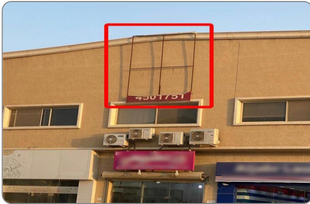
شكل (18): وجود الأساسات الحديدية لتثبيت اللوحات المزلة
