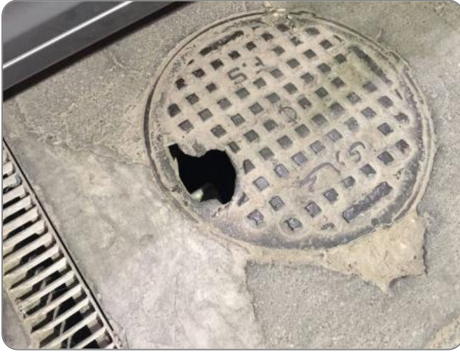
شكل (8): تغطية خزانات الصرف الصحي بأغطية غير متوافقة مع الاشتراطات البلدية
