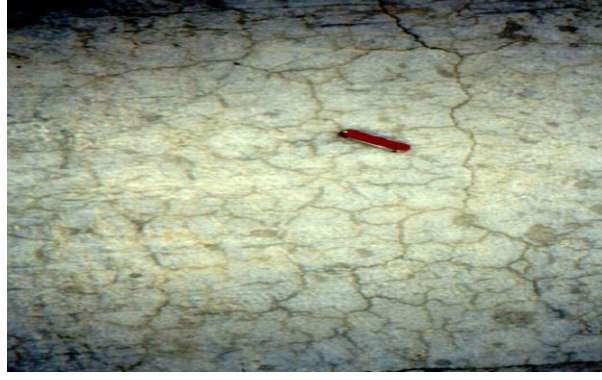
شكل رقم (1) شكل شروخ الانكماش
