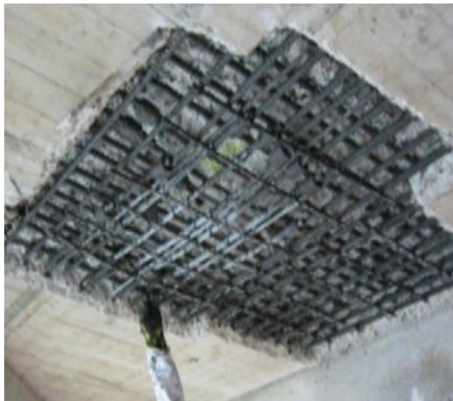
شكل رقم (20): إصلاح حديد تسليح البلاطات
