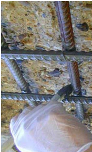
شكل رقم (20): إصلاح حديد تسليح البلاطات
