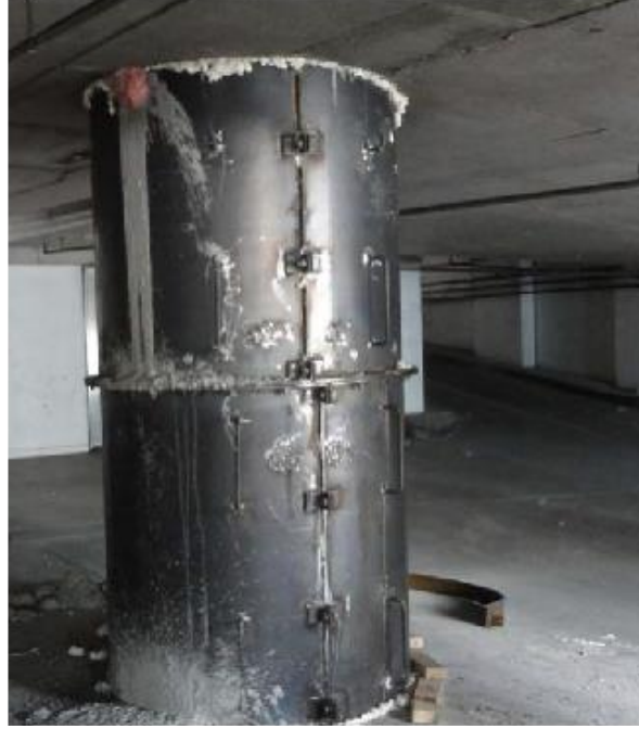
شكل رقم (18): نموذج لعمل قميص تدعيم عمود بالإحاطة الكاملة بالصلب
