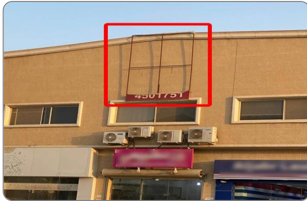
شكل (18): وجود الأساسات الحديدية لتثبيت اللوحات المزالة
