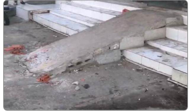
شكل (1): عدم تنفيذ منحدر للأشخاص ذوي الإعاقة وفق الأدلة المعتمدة
