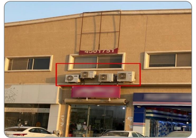
شكل (3): وحدات تكييف منفصلة (مخالفة) في واجهة المبنى أو أساسات حديدية لتثبيت لوح سابقة
